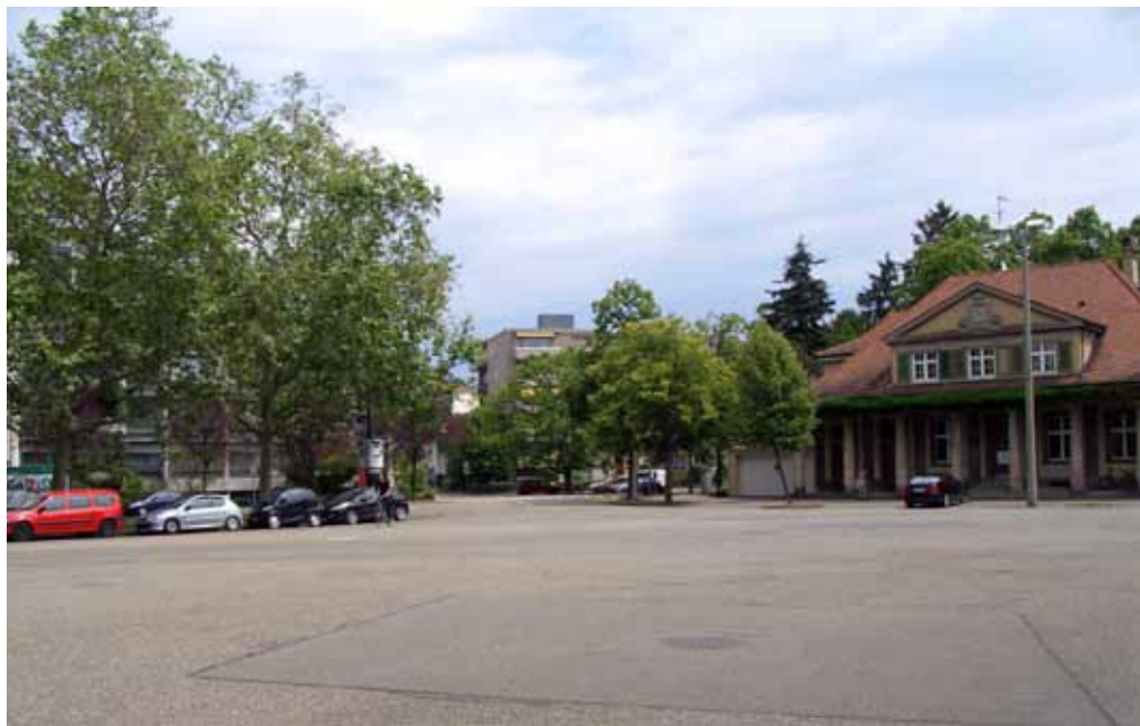
Der Wielandplatz - eine der „Baustellen“ in der Gestaltung des öffentlichen Raums in Basel-West. Foto: Philipp Karger
